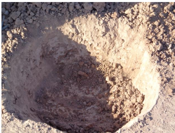
Imagen 4: pozo correctamente cavado.
