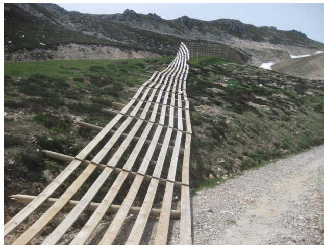
Figura 59.- Efecto de los empujes por nieve en el Puerto de San Isidro. LIFE09.
