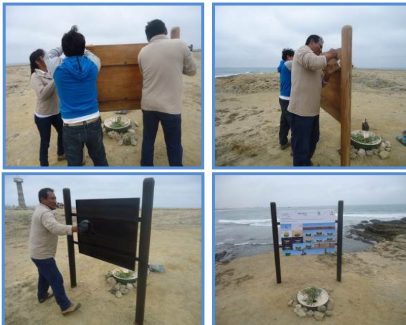
Pulida, pintada de estacas y colocacion de nuevo banner.
