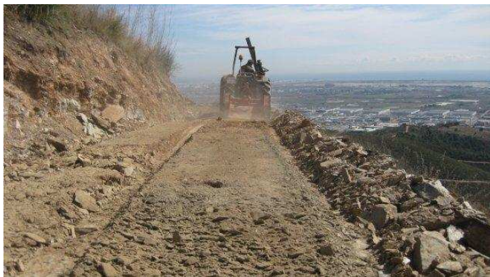
Preparación del terreno
