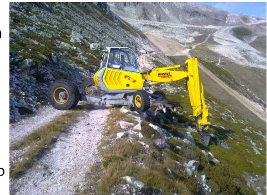
Preparación terreno con retroaraña en San Isidro
